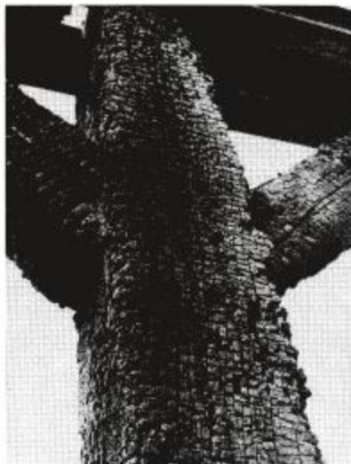
Abbildung 2 Dieser Tragbalken zeigt deutlich die Holzkohleschicht, die den unverbrannten Holzkern vor weiterer Zerstörung schützt und somit die Rettung von Menschenleben und die Sicherstellung wichtiger, kostbarer Güter ermöglicht (Foto: AGH)
