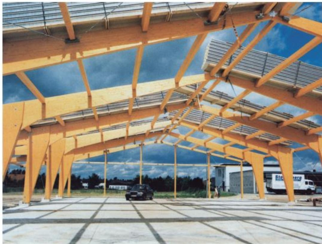
**HÖHERE FESTIGKEITEN** gegenüber Vollholz lassen sich nach Angaben der Firma Timmermann durch Verleimung des nachwachsenden Naturproduktes erzielen. Dank dieser Technik ist es problemlos möglich, stützenfreie Hallenkonstruktionen mit großer Spannweite zu errichten. Ein beeindruckendes Bei-
