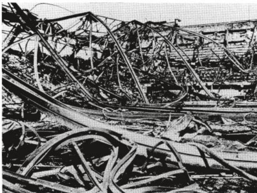
Abbildung 3 Ein unentwirrbares Knäuel von verbogenen Stahlträgern – das ist alles, was von dieser riesigen Produktionshalle in den USA nach einem Großbrand übrigblieb. Durch die enorme Hitzeentwicklung dauerte es nur wenige Minuten, bis die Halle in sich zusammenstürzte (Foto: AGH)
